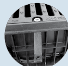
Montaggio della zanca
